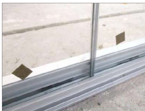
Imágenes 5 y 6 Instalación de los vidrios en el sistema de soporte
